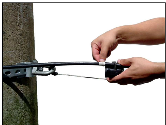
FIG.1 – Marcação do cabo
