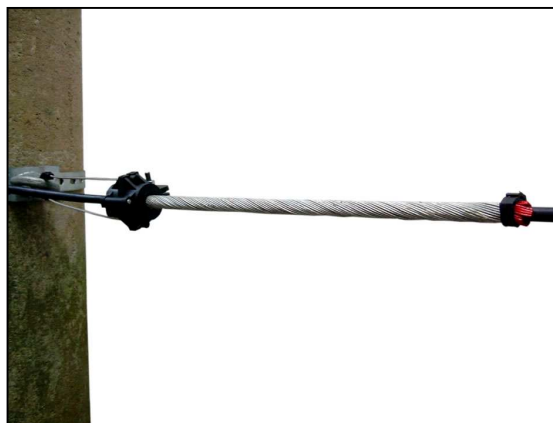
FIG. 9 – Conjunto de Ancoragem aplicado
