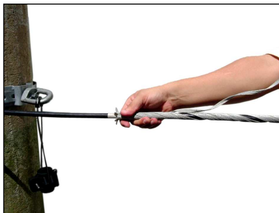
FIG. 3 – Montagem da Armadura – demais elementos
